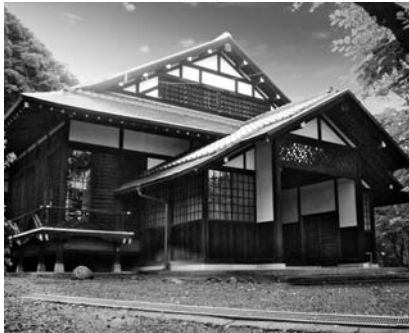
※施工例(旧社会教育館)弊社の礎となる最初の建造物
