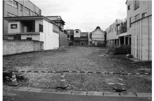
新商工会館建設地（北側より）
