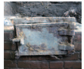
燃焼施設の鉄扉
