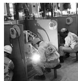
溶接試験の様子
